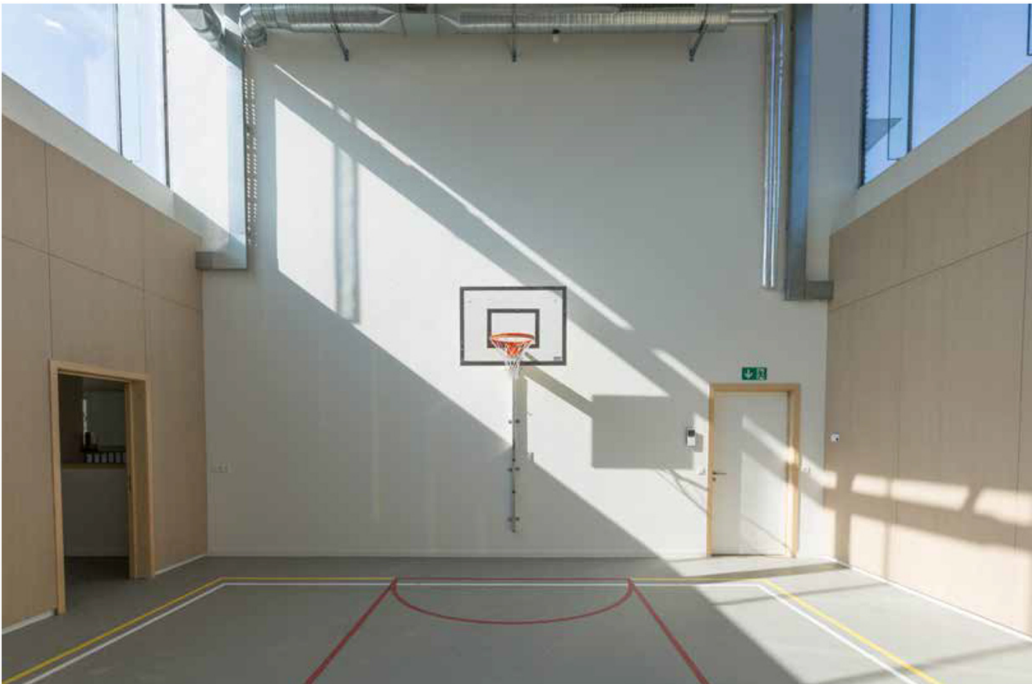
De sporthal stijgt vier meter boven het dak uit om zoveel mogelijk daglicht binnen te laten.
