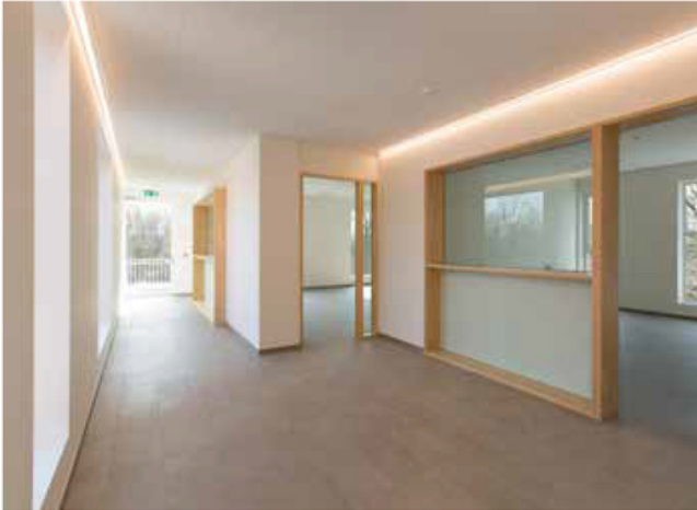
Voor het binnenschrijnwerk werd met hout en akoestisch plaatmateriaal gewerkt.
